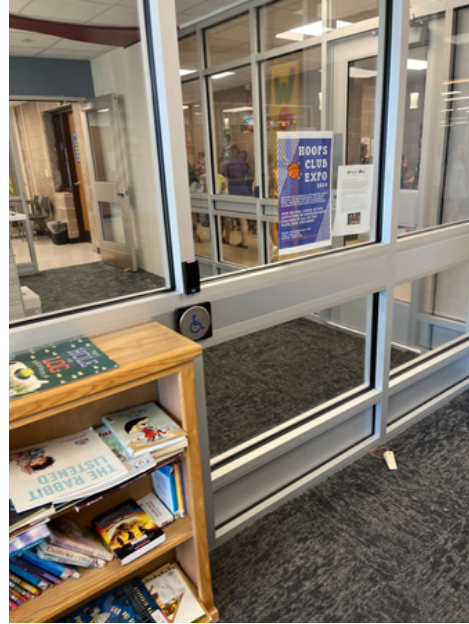
Handicap Door buttons indtalled.
