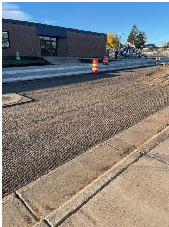
Buslane Sidewalk Pour Complete
