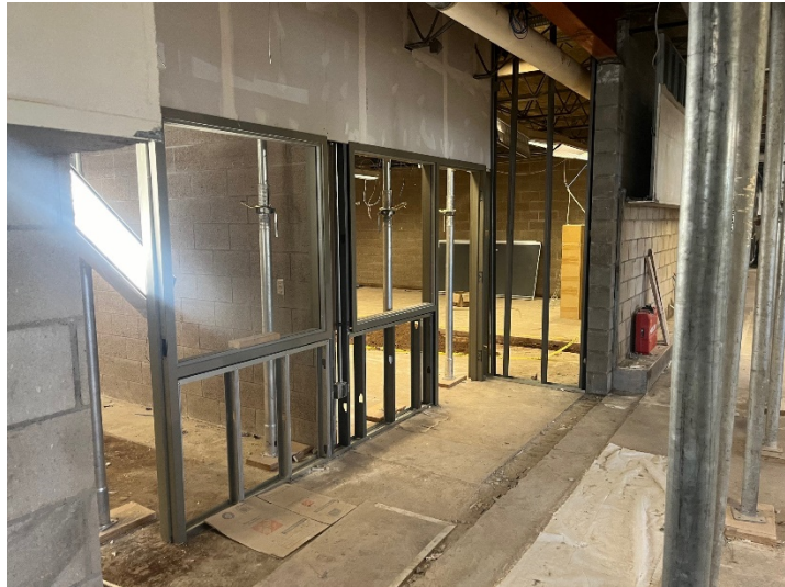
Steel Stud Framing areas.
